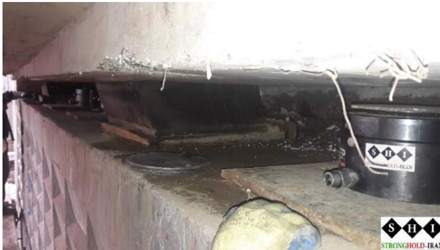
شکل ۶- تغییرشکل ایجاد شده در بالشتک الاستومری در اثر انبساط و انقباض و بارهای ترافیکی
