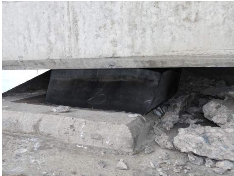
شکل ۵- لغزش بالشتک و بیرون زدگی از لایه گروت زیرین
