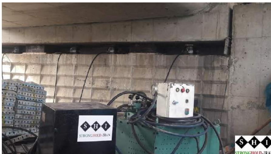
شکل ۸- چیدمان جک‌ها در اطراف بالشتک
