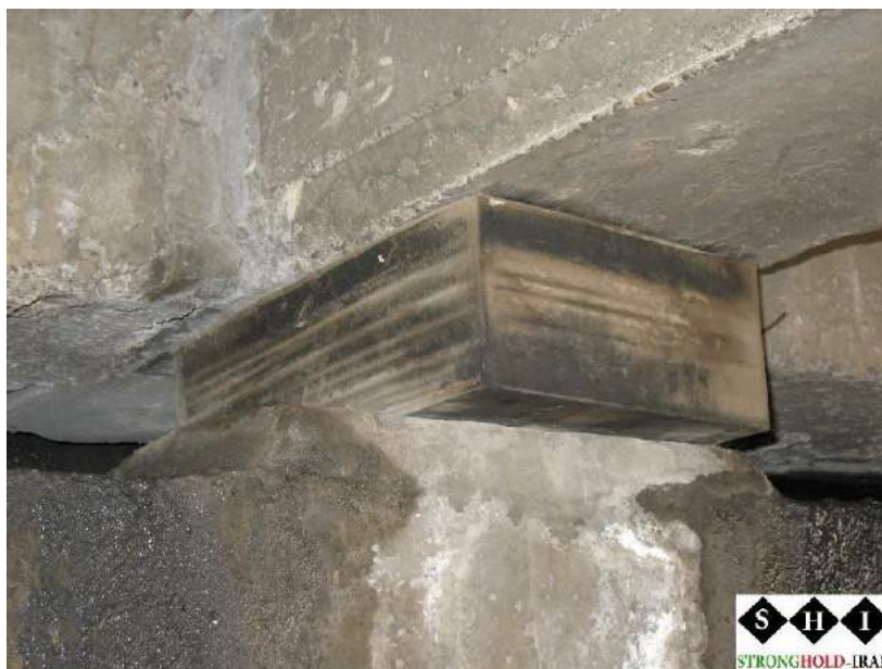
شکل ۶- لغزش بالشتک بدلیل عدم در نظرگیری حداقل بار فشاری در طراحی اولیه
