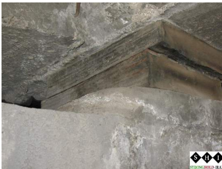
شکل ۱- گسیختگی بالشتک در اثر جداشدگی لایه‌های لاستیک و فولاد
