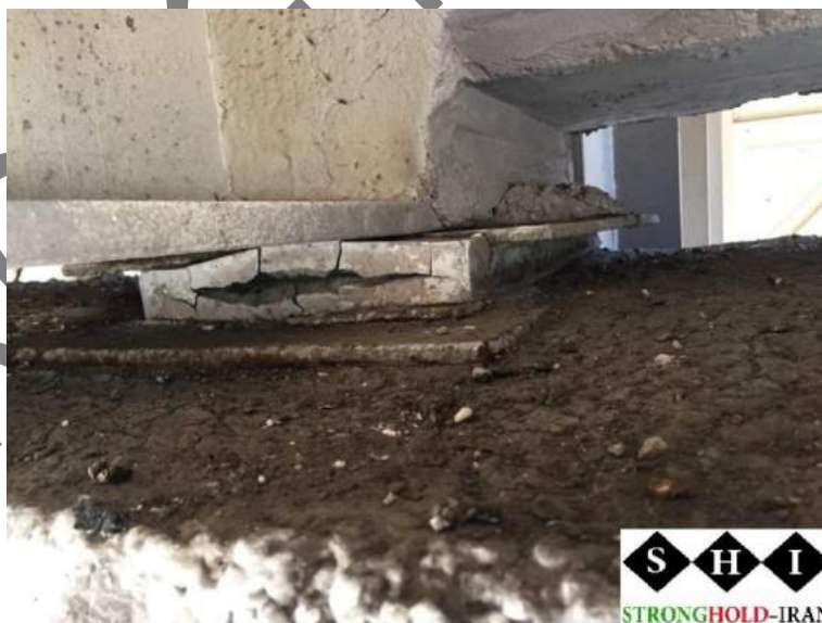
شکل ۳- خرابی بالشتک در اثر سپری شدن عمر مفید الاستومر
