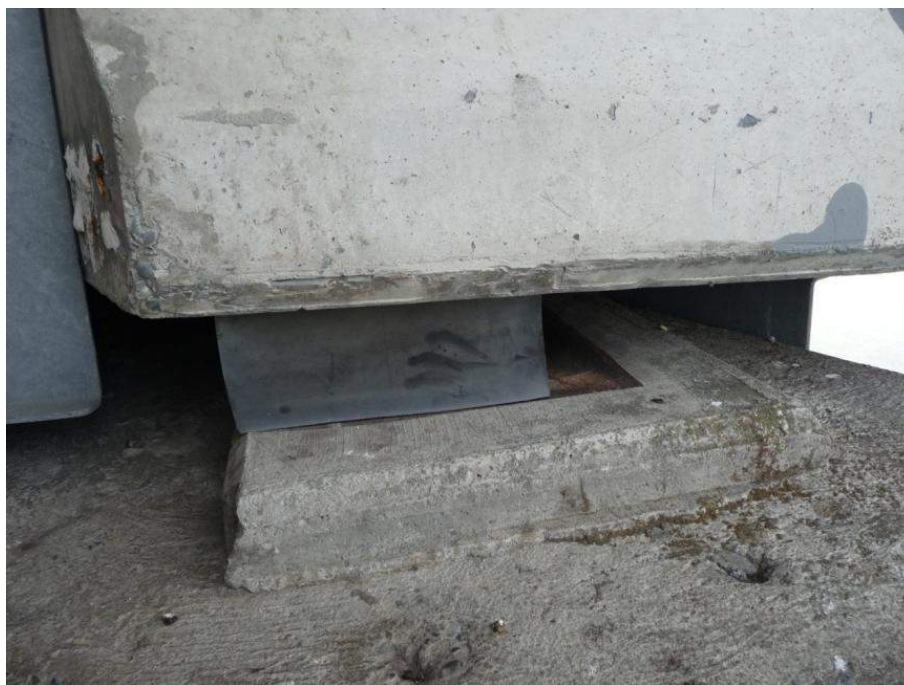
شکل ۵- لغزش بالشتک الاستومری تحت بارهای اتفاقی از جمله زمین لرزه
