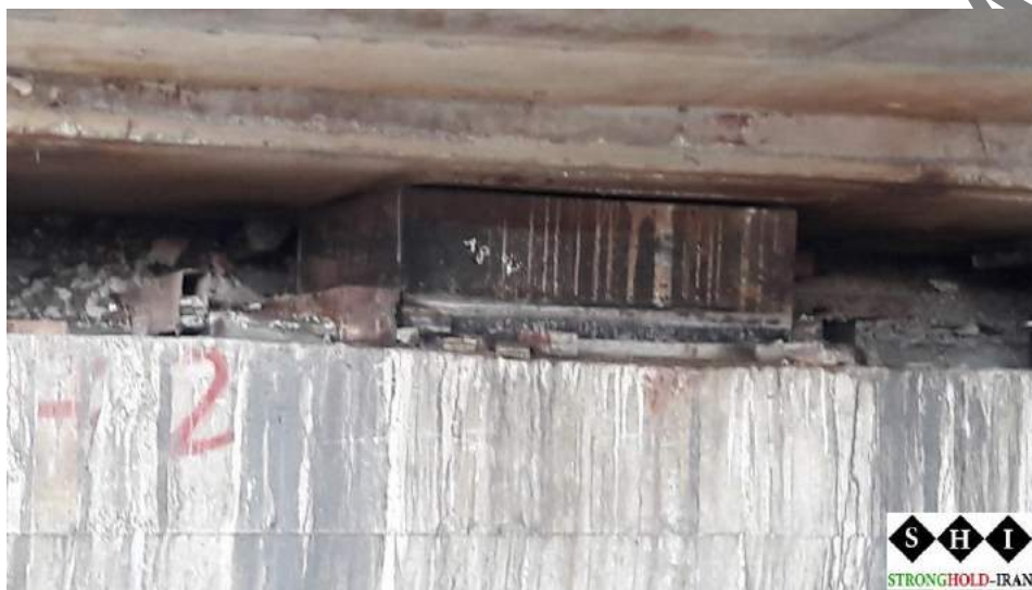
شکل ۱۳- خرابی لایه‌ی گروت زیرین بالشتک در اثر بلند کردن عرشه
