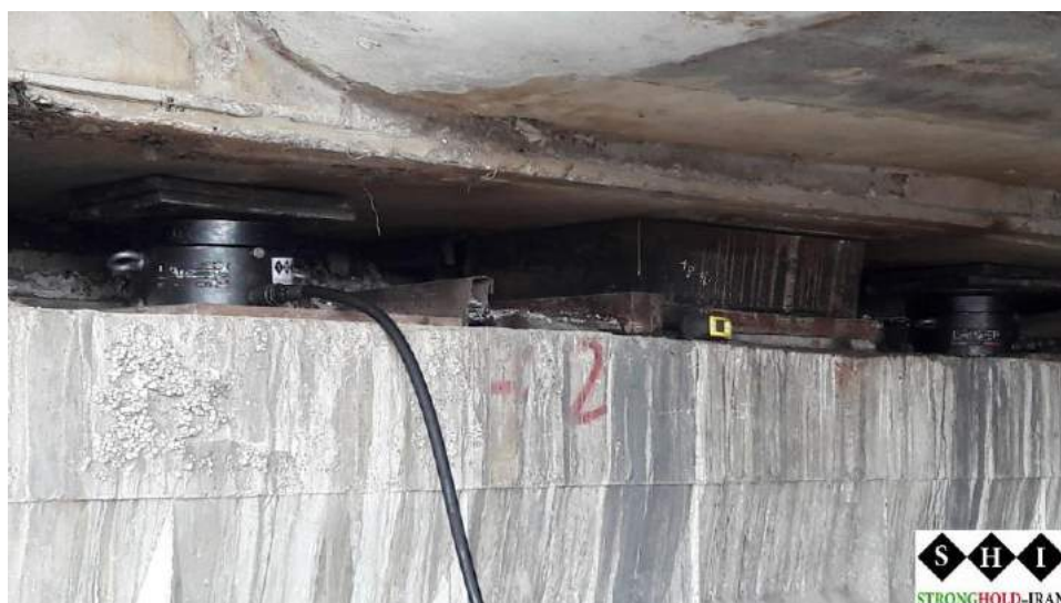
شکل ۱۰- استفاده از ورق‌های با ابعاد بزرگ در بالا و پایین جک برای جلوگیری از برش پانچ
