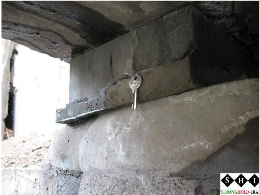
شکل ۹- جدایی لایه لاستیک و فولاد بدلیل عدم چسبندگی مناسب
