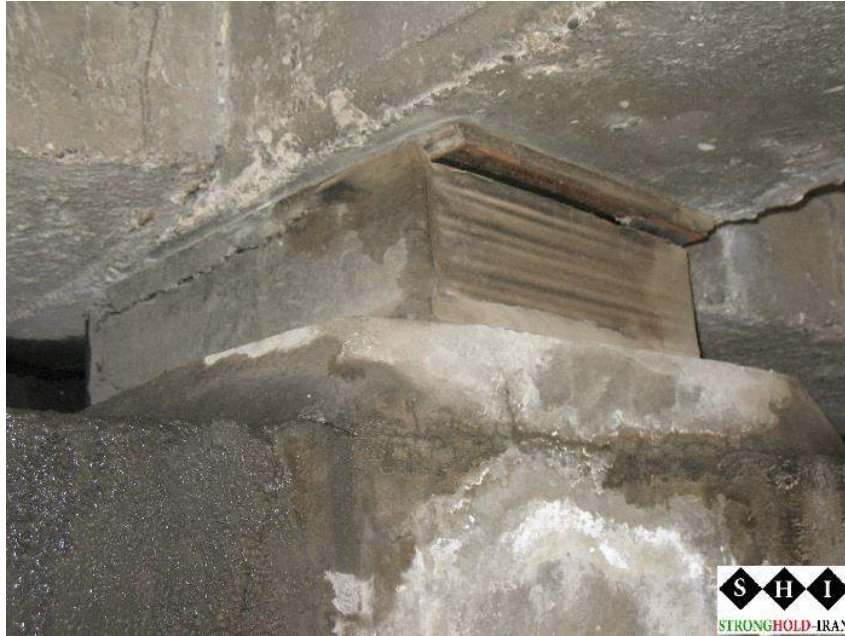
شکل ۷- موجدار شدن بالشتک و جدایی لایه لاستیک و فولاد بدلیل عدم چسبندگی مناسب
